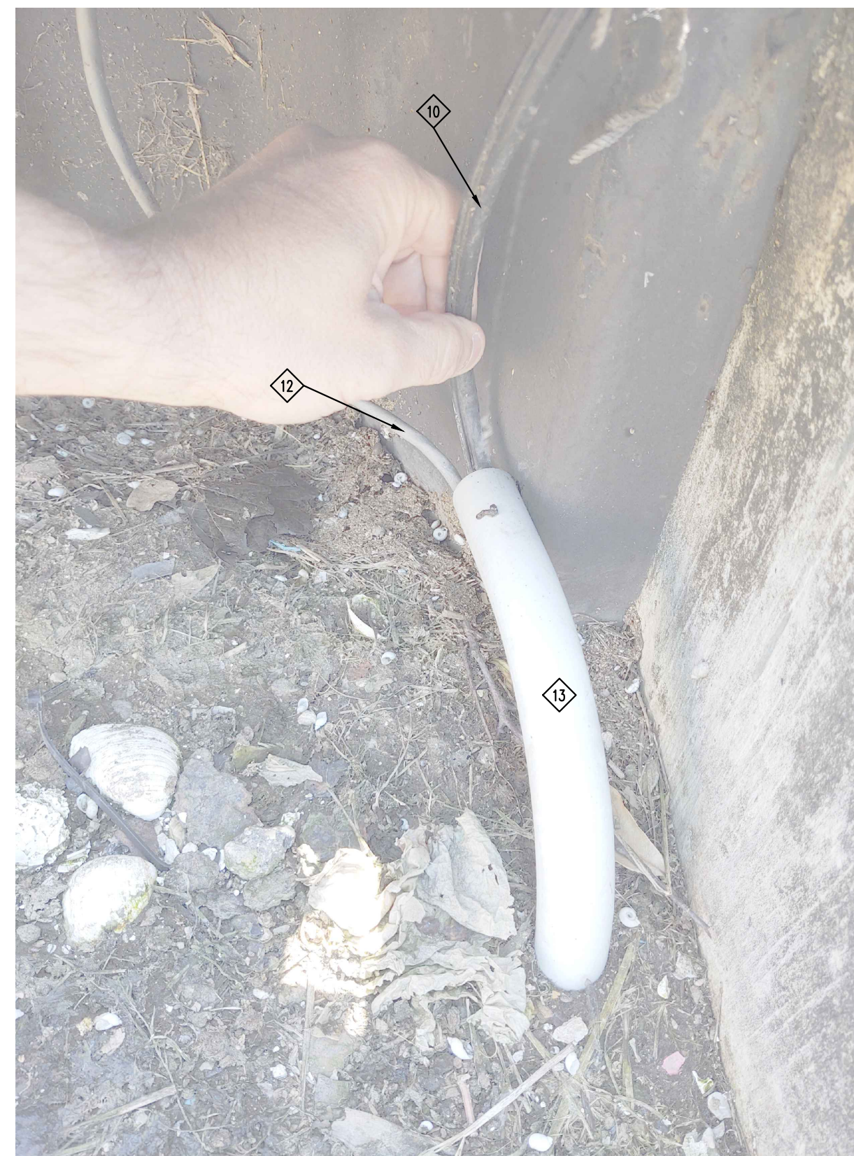
3 CLOSEUP - SCADA CABLES SCALE: N.T.S.
