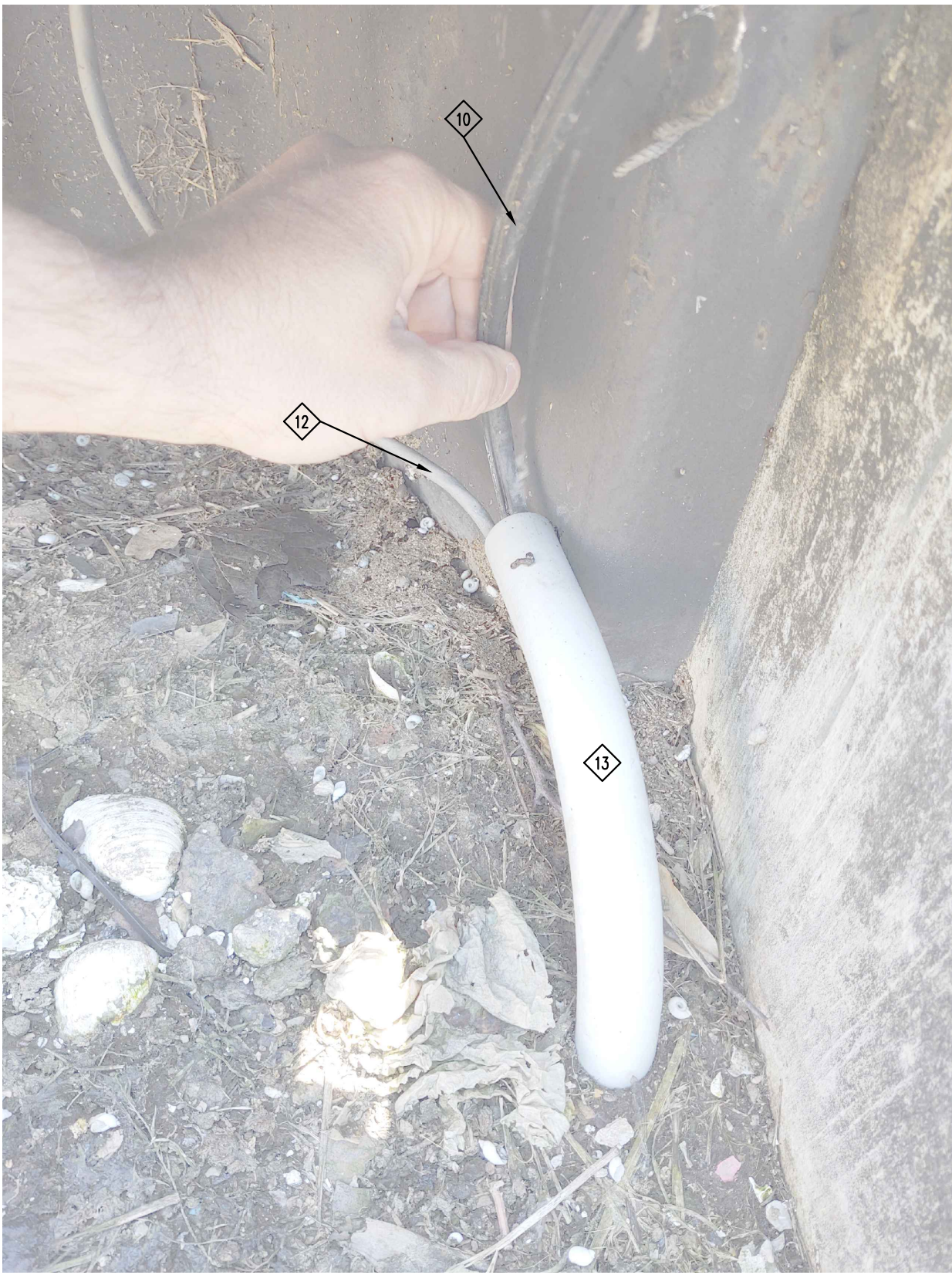
3 CLOSEUP - SCADA CABLES SCALE: N.T.S.
