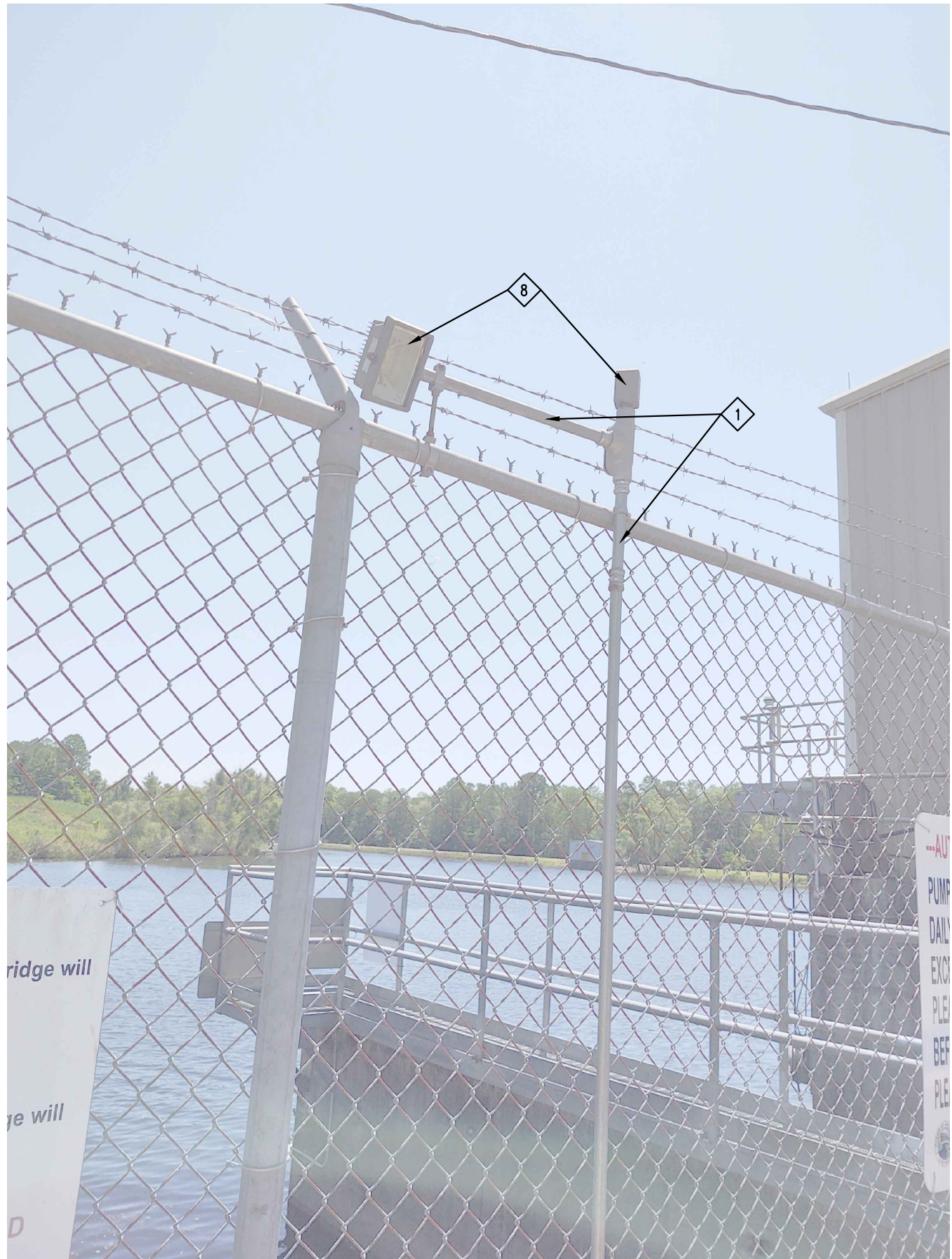
6 EXISTING PHOTOCELL AND FLOODLIGHT SCALE: N.T.S.
